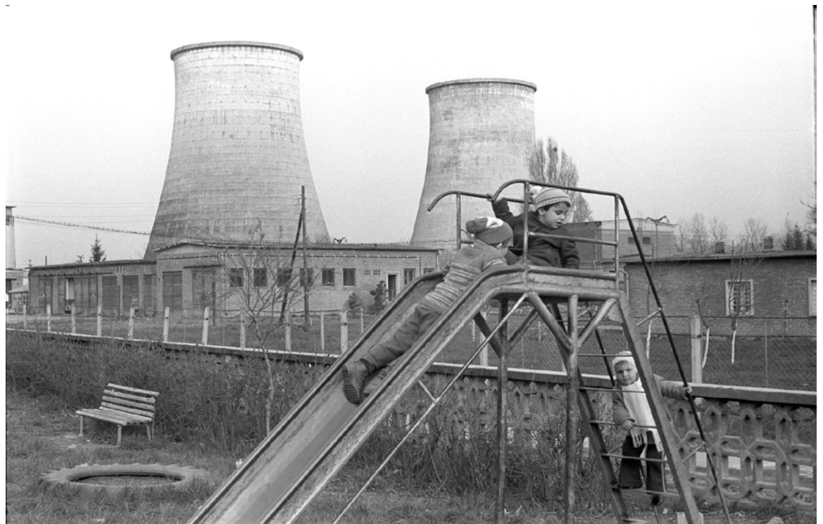
ERDÉLYI Lajos: Óvoda, Vörös Csillag Hőerőmű, Gyulakuta , 1980 Zoltai András / Blinken OSA Archívum HUNGART © 2025
